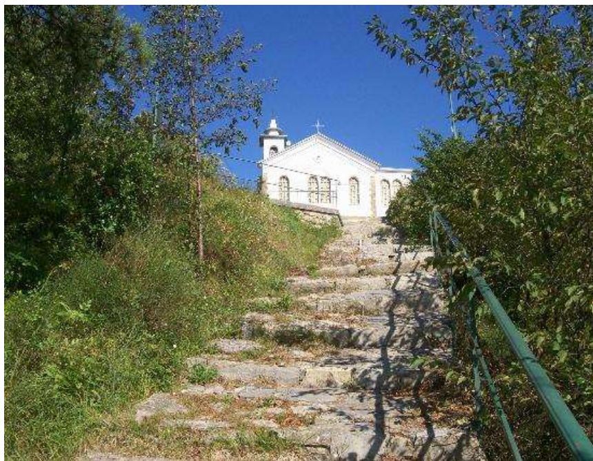
La scalinata di accesso al Santuario di N.S. di Caravaggio
